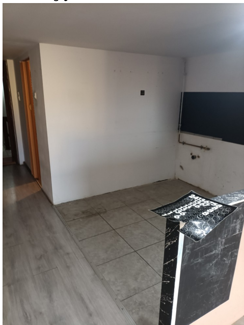
Zdjęcie lokalu do remontu
