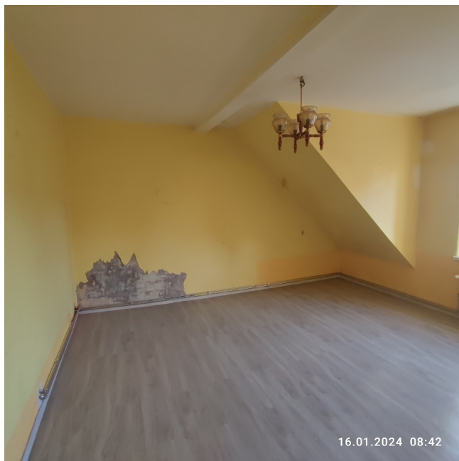
Zdjęcie lokalu do remontu
